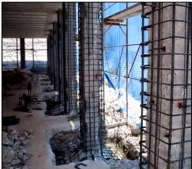
Fig.12 Armado de Encamisado de Hormigón.
